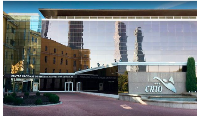
Imagen del edificio del Centro Nacional de Investigaciones Oncológicas (CNIO).
